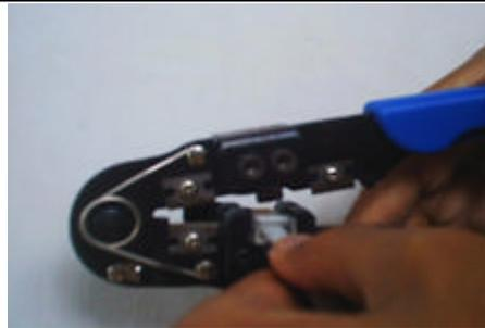
Gambar Menjepit kabel menggunakan Crimping
